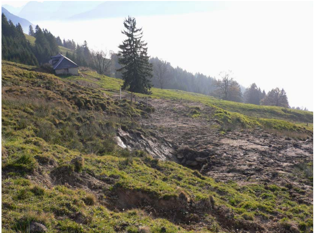
Oberhag, Entwässerung und Erstellung Weg
