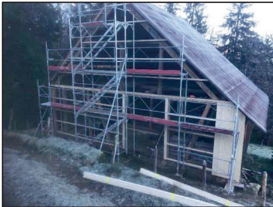
Sanierung Nordfassade unterer Fährbergstall
